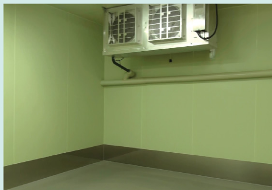
2F 冷凍庫内
